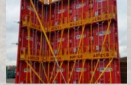
Chantier Lycée Français
