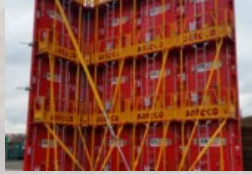
Chantier Lycée Français
