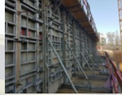
Chantier cour de justice
