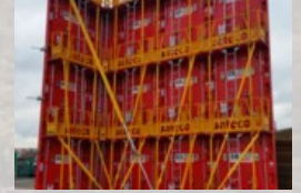
Chantier Lycée Français
