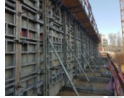
Chantier cour de justice
